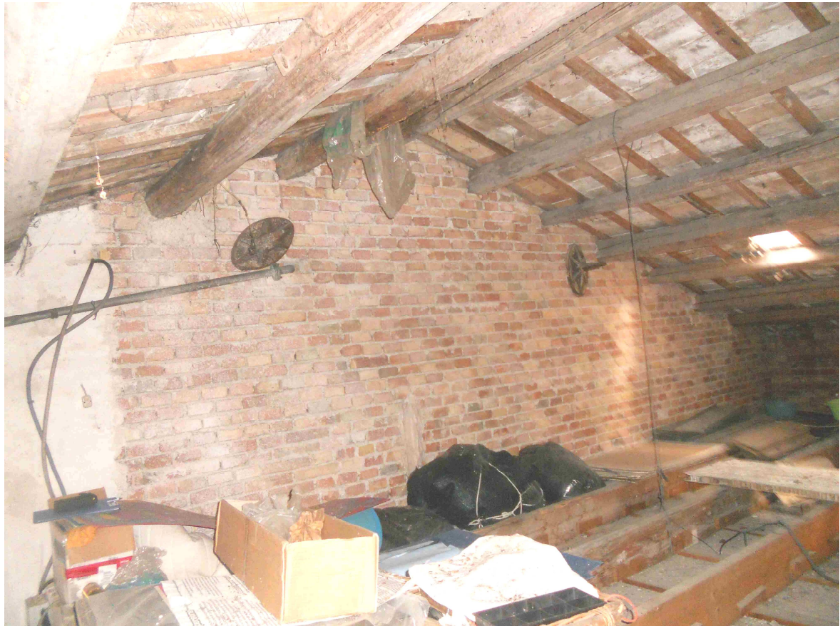
Foto n.24 Sottotetto – materiale depositato
