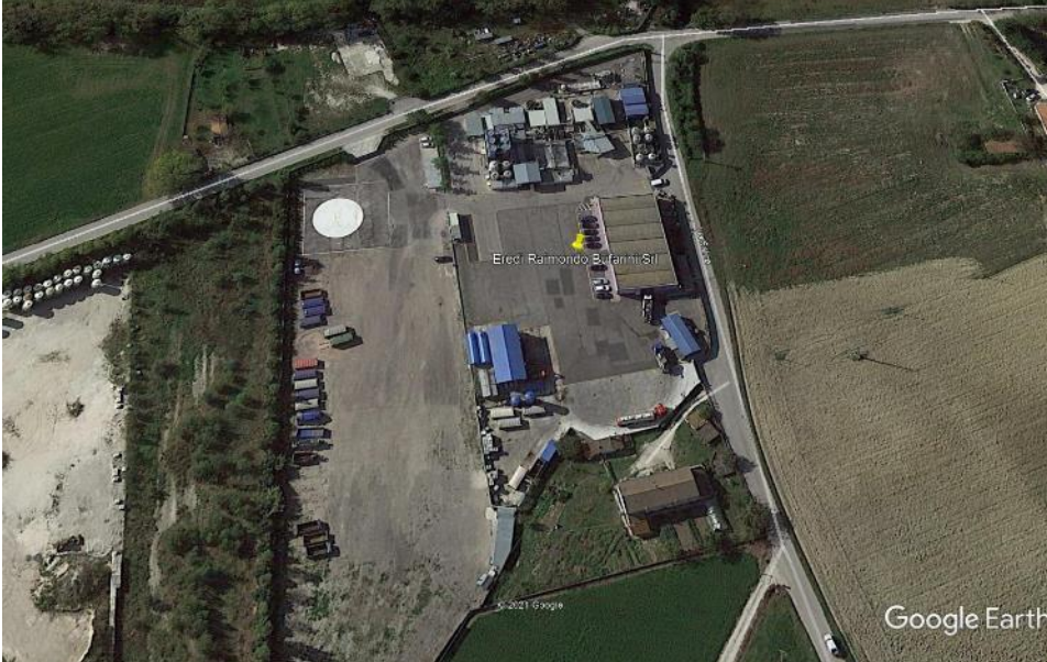
Figura 3 - Foto Panoramica dello stabilimento vista da est
