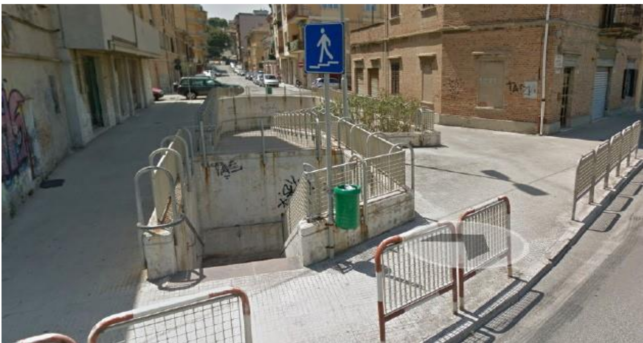
Fig. 5: Sottopasso pedonale "Villanova" – uscita lato via Stamura
